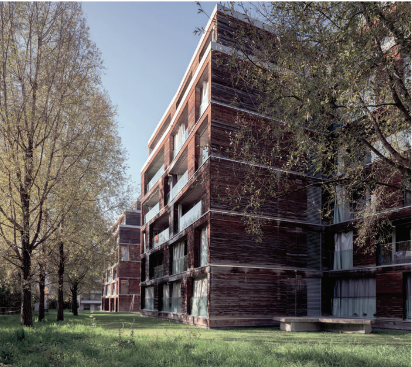
Façade sud de l’immeuble du chemin de Bonne-Espérance 32
