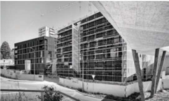
Place de la Sallaz 4-5 - en fin de second-œuvre
