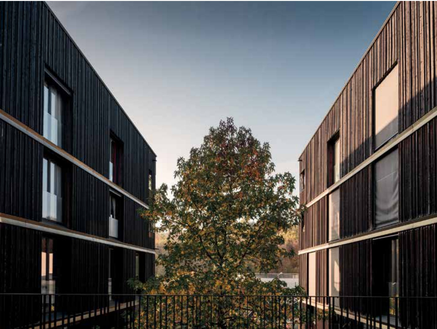
L’espace central - Place de la Sallaz 4-5
